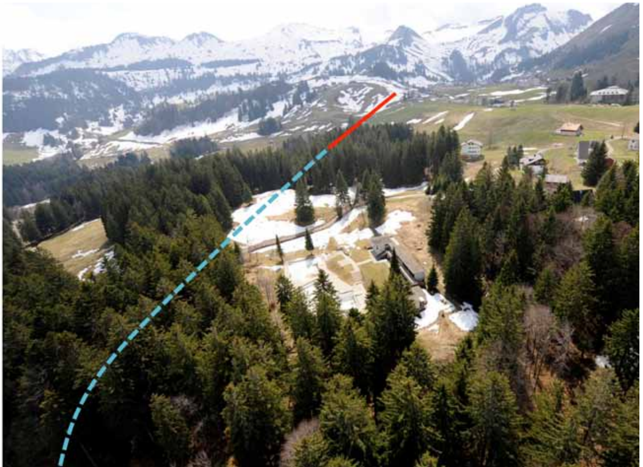
Neue Standseilbahn Parkplatz Hinteres Schlattli – Zentrum Stoos: Tunnel unter dem Schwimmbad
