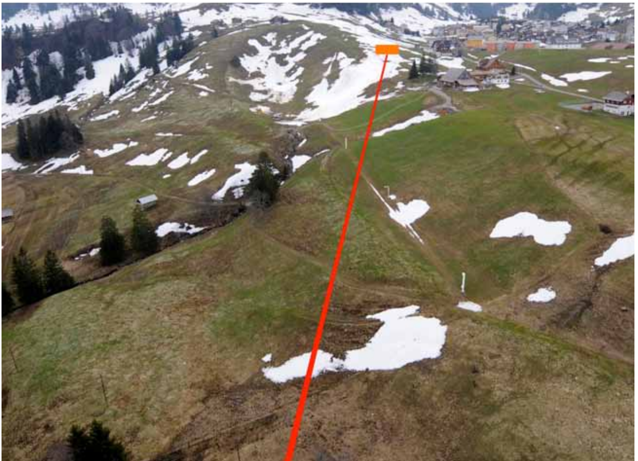
Neue Standseilbahn Parkplatz Hinteres Schlattli – Zentrum Stoos: Bergstation hinter dem Restaurant Klingenstein
